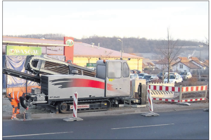
Die Firma Inexio hat mit den Bohrspülungen in Gölheim begonnen, die Bilder zeigen das Bohrgerät vor dem Wasgau-Markt. FOTO: PRIVAT
